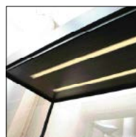
Toit éclairant par néons avec diffuseurs
